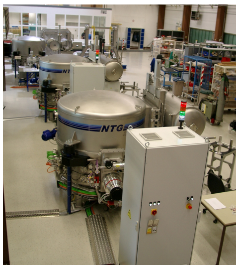
3 IBF 500 Anlagen mit Doppelschleusen
